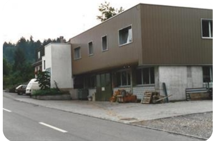
Die Werkstatt – ursprünglich mit Flachdach
